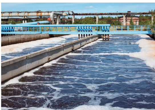
Очистка сточных вод
